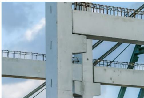
Obr. 1 Využitie krátkej konzoly v praxi: a) prefabrikovaná konštrukcia; b) hala s mostovým žeriavom.
