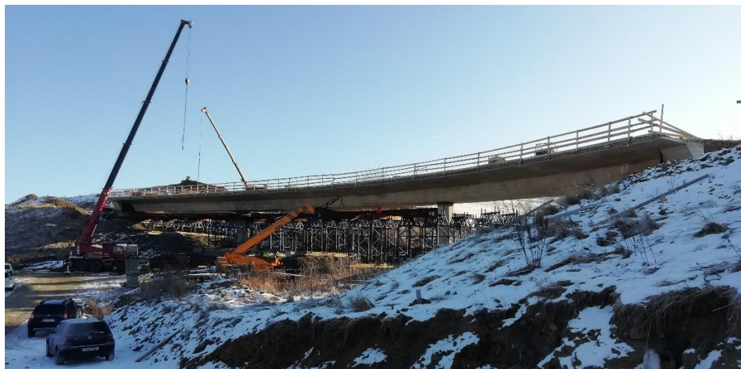
Obr. 4 - SO210 – Počas výstavby
