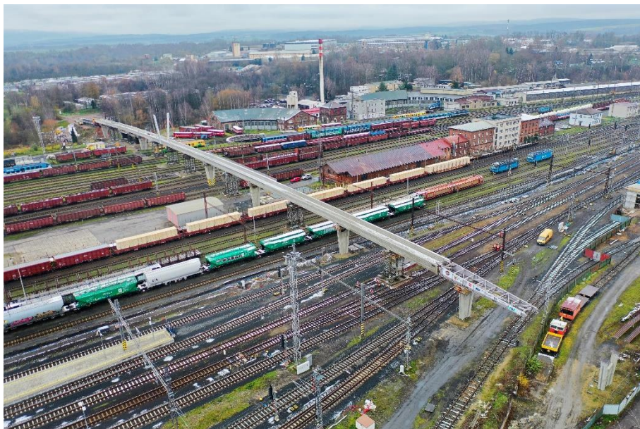
Obr. 3 Nosná konstrukce během výsunu
