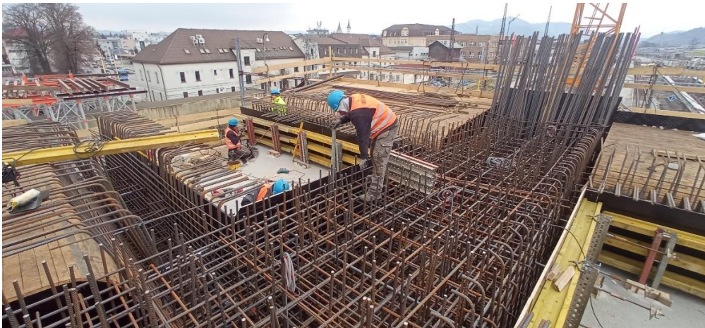
Obr. 7: Armovanie priečne predpätého priečnika P4
