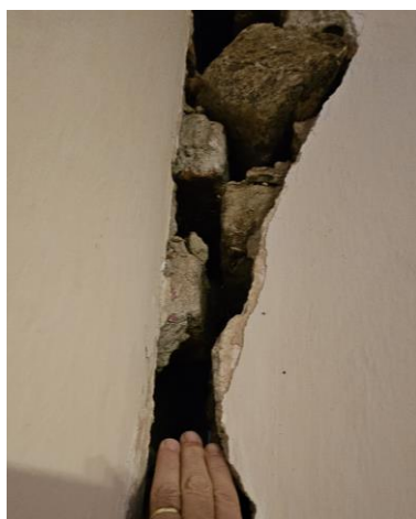
Obr. 6 Trhliny v nosných konštrukciách vo vybraných, najviac zasiahnutých objektoch [Zdroj: SKSI]
