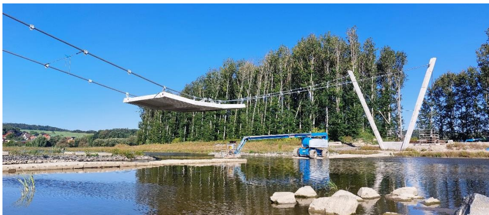
Obr. 5 – Montáž segmentů
