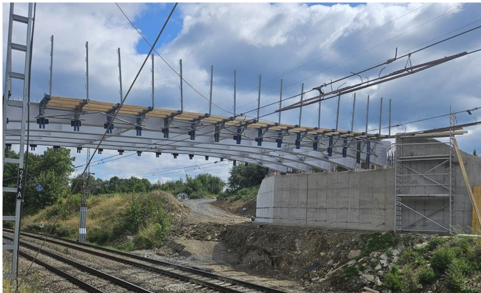
Obr.5 Pohľad na uložené oceľové nosníky
