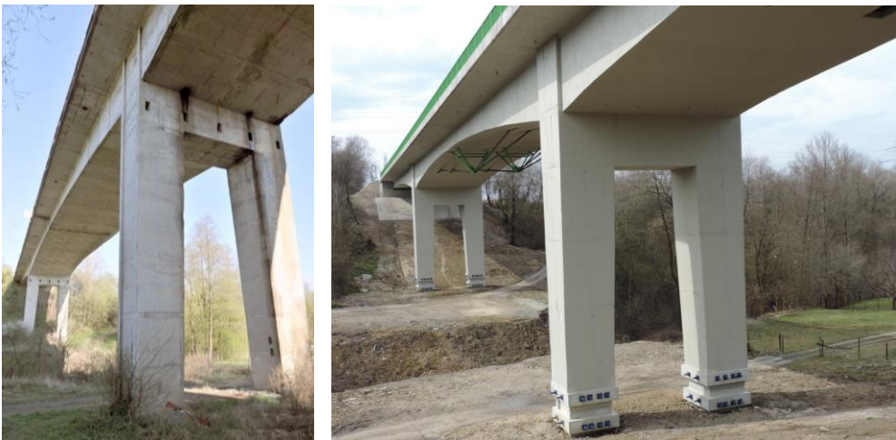
Obr. Most Zlatné nad údolím stav pred a po rekonštrukcii.
