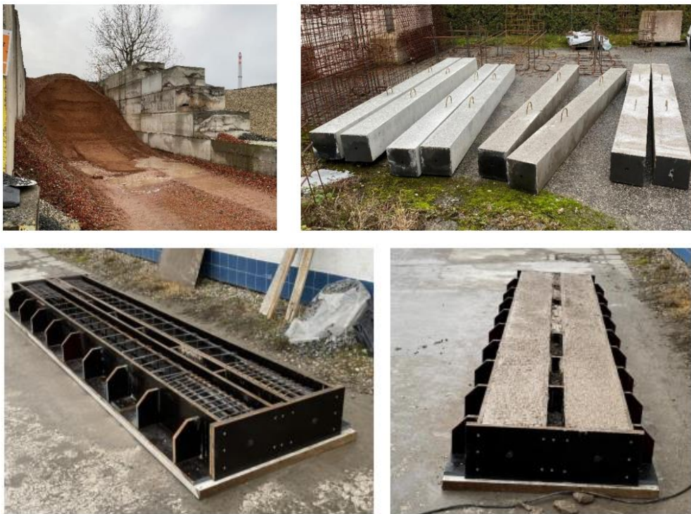
Obr. 2: Betonáž stĺpov
