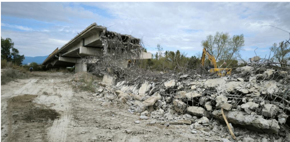
Obr. Most cez Váh vo Veľkých Bierovciach demolácia nosnej konštrukcie 10/2024.
