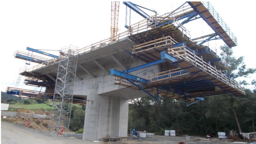
Obr. 6 – SO211 Zárodok s 2 etapou letmej betonáže
