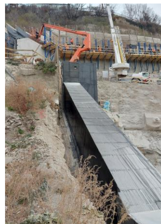
Obr.15 –Priečný rez konštrukciou podzemného kabelovodu v svahu zabezpečený proti zosuvu kotvami 2 x 2 x WR 75 (vľavo) a celkový pohľad na kabelovod (vpravo)
