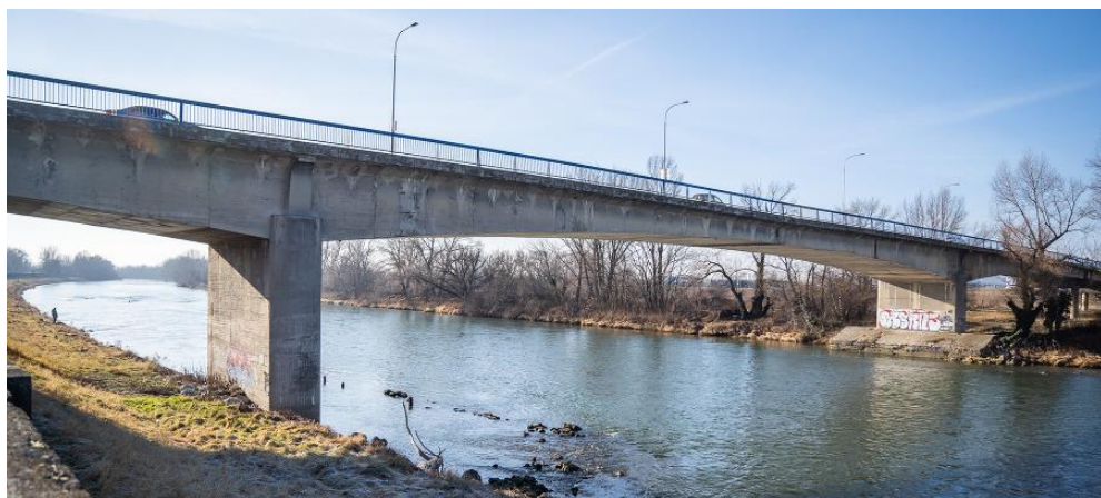
Obr. Most cez Váh v Hlohovci pred rekonštrukciou.
