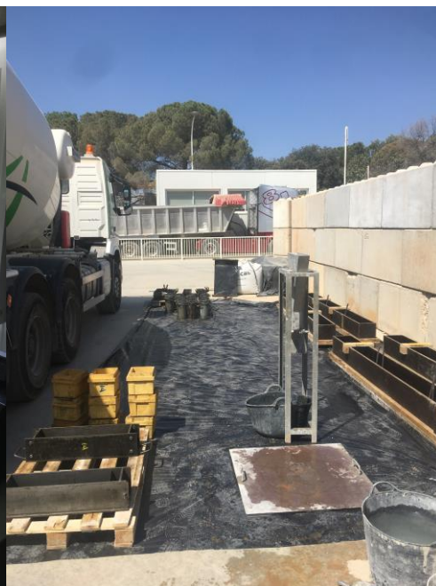
Obr. 10: Pripravené pracovisko na betonáž
