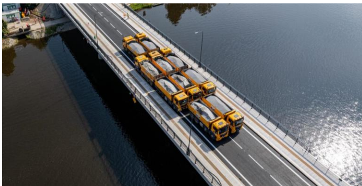
Obr. 5: Pohľad na statickú zaťažovaciu skúšku mosta – súprava 10 vozidiel
