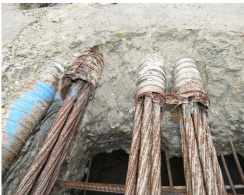
Obr. Korózia predpätia v kábl. kanálikoch bez injektáže
