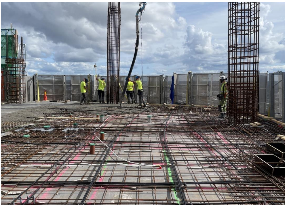
Obr. 7: Betonáž predpäť dosky
