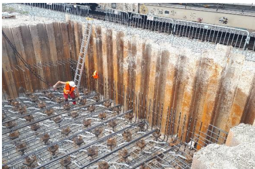
Obr. 3: Realizácia základu P4
