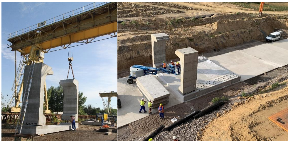
Obr. 4: Skúšobná montáž – vľavo; reálny postup výstavby vpravo
