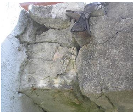
Obr. 6 Dilatační profil
