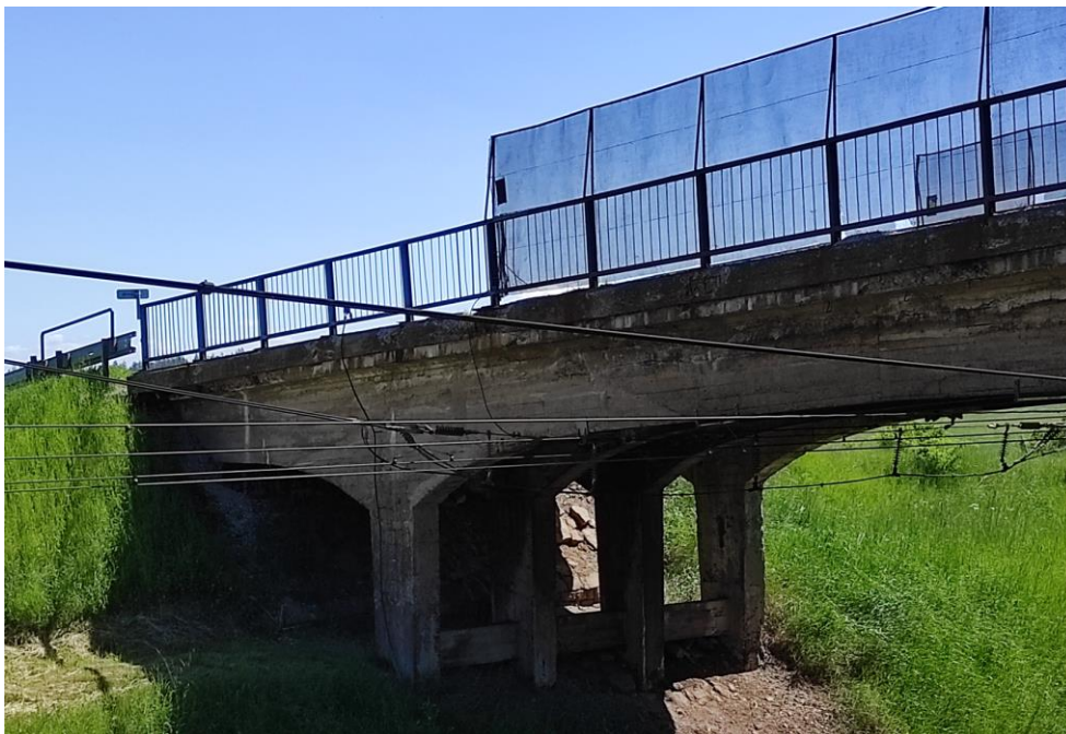
Obr.1 Pohľad na pôvodný most
