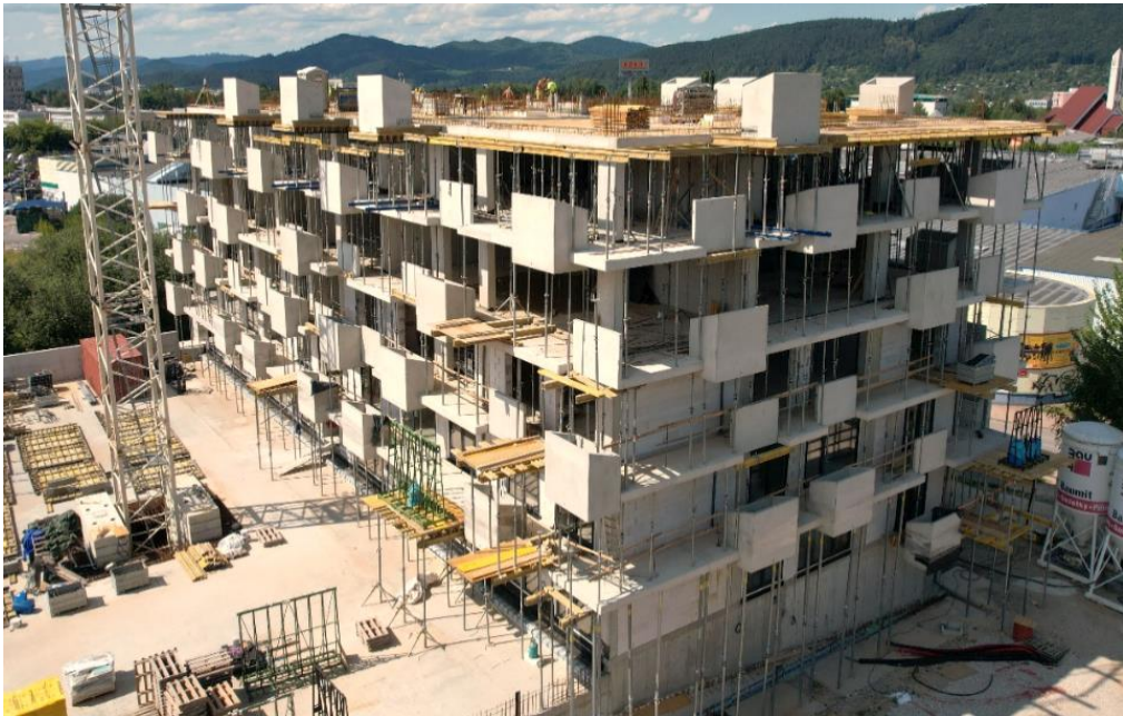
Obr. 10 – Obj. D - realizácia nadzemných podlaží a balkónov s prefabrikovanými kvetináčmi [9]
