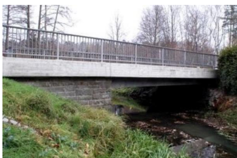
most 109 blízko Kleinsaubernitz, Nemecko 4 vrstvy uhlíkového betónu na spodnej strane 2,5 cm výstužná vrstva
