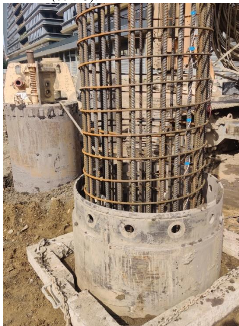
Obr. 12: Výstroj pilóty
