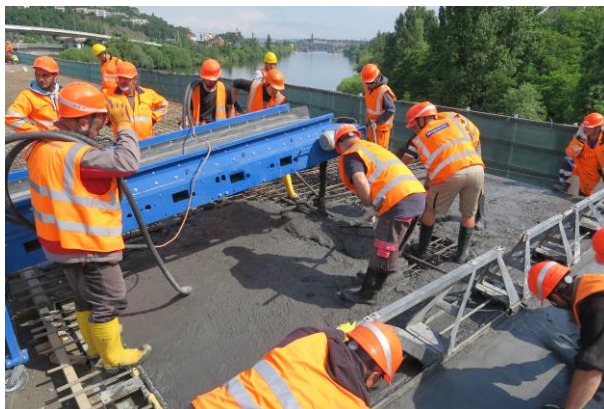
Obr. 3 Ukládka vrstvy UHPC ve 3. etapě dopravníkem a vibrační lištou
