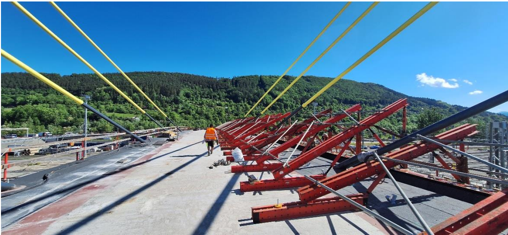
Obr. 9: Nosný systém debnenia ríms
