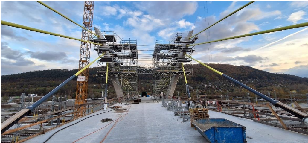
Obr. 8: Inštalácia a napínanie závesov mosta
