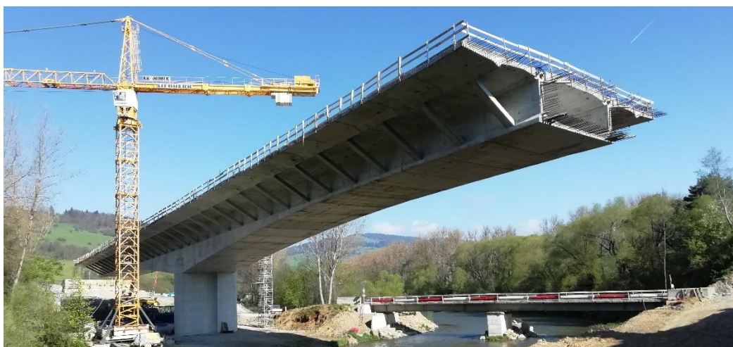
Obr. 7 – SO211 Odstránenie vozíkov letmej betonáže po poslednej etape
