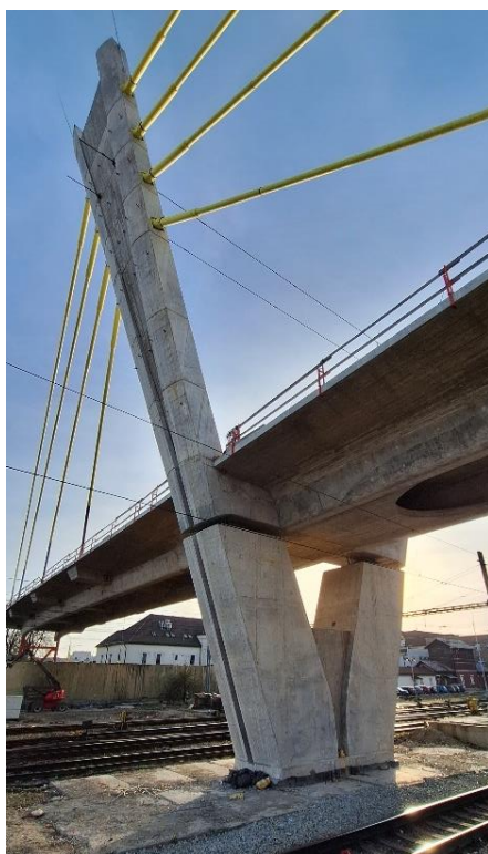
Obr. 5: Spodná stavba – pilier P4
