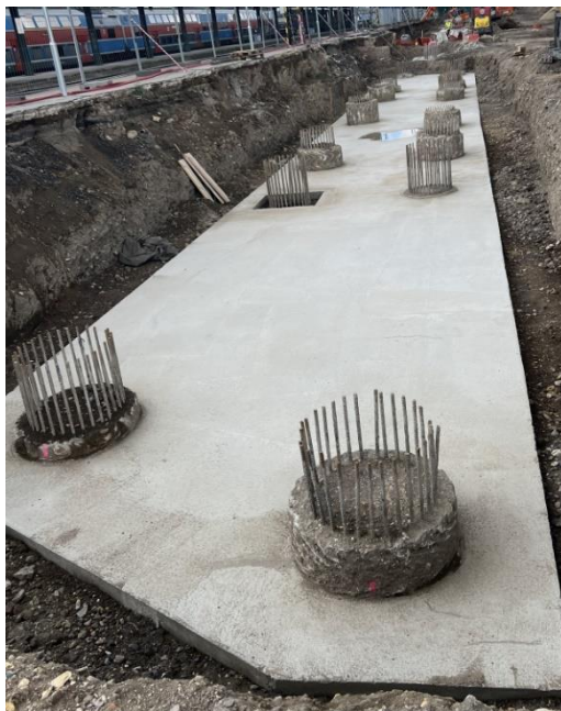
Obr. 13: Usporiadanie pilót na základovej doske
