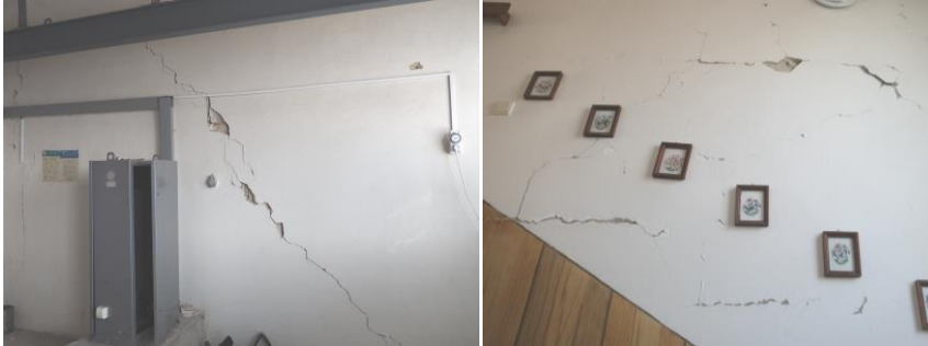
Obr. 9 Uvoľnené a popraskané omietky [Zdroj: SKSI]
