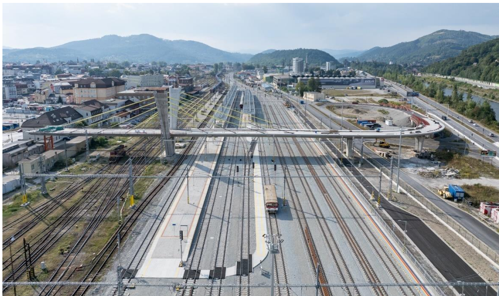
Obr. 2: Aktuálny stav mosta – finalizácia etapy I, Foto: STRABAG
