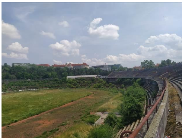
Obr. 1 Celkový pohled na současný stav tribuny a hřiště
