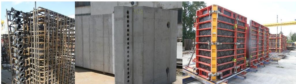
Obr. 3: Pohľad na výrobu stenového prvku
