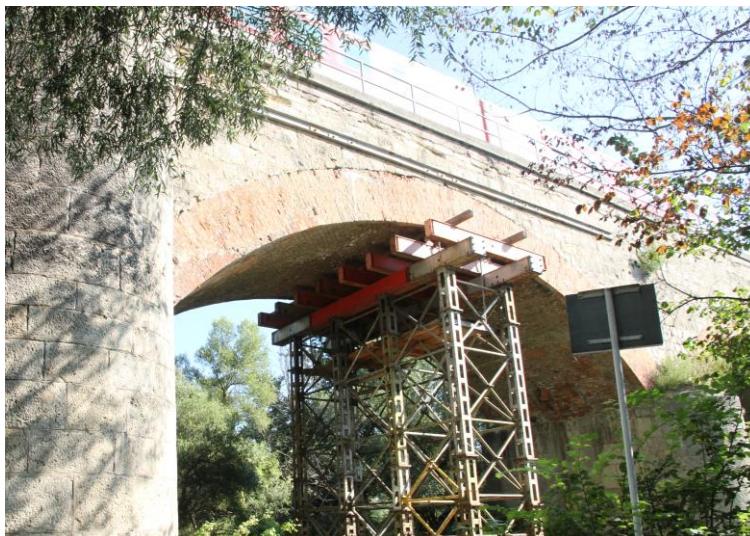
Obr. 3: Provizórne podopretie klenby č. 1
