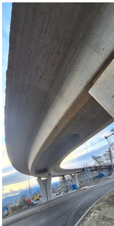
Obr. 6: Spodná stavba – pilier P6
