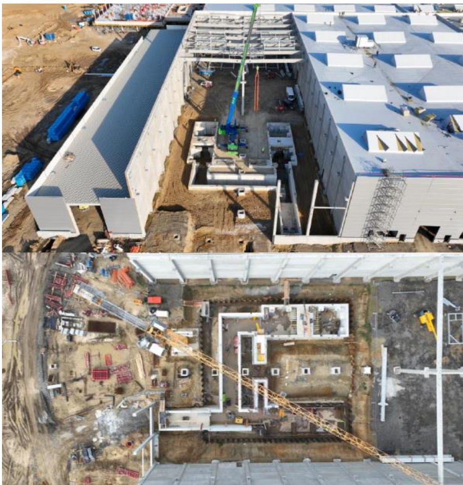
Obr. 2: Výrobná hala, pohľad na technologické jamy
