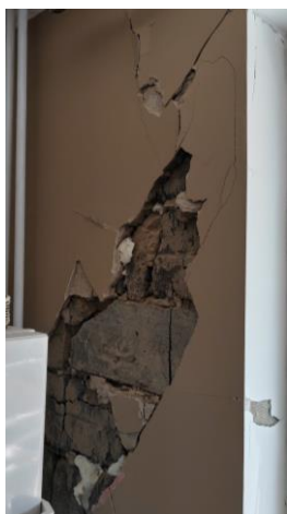
Obr. 6 Trhliny v nosných konštrukciách vo vybraných, najviac zasiahnutých objektoch [Zdroj: SKSI]
