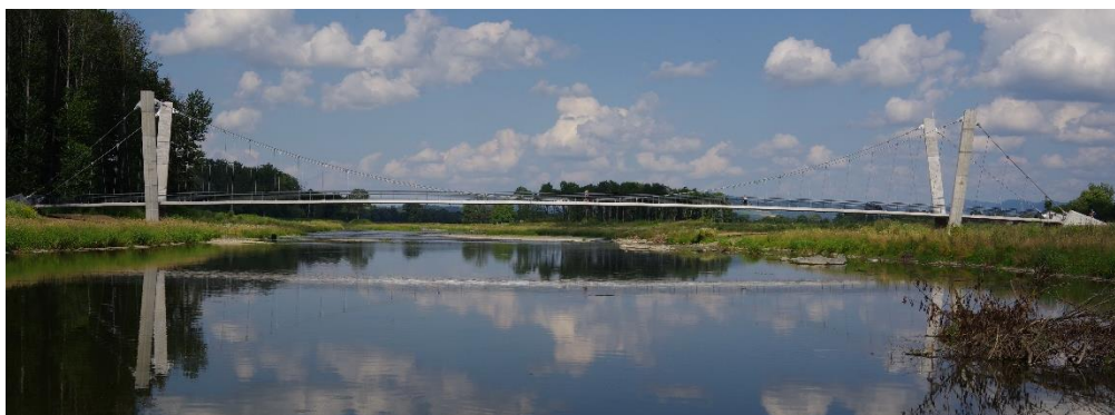
Obr. 1 – Lávka přes Bečvu
