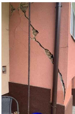
Obr. 6 Trhliny v nosných konštrukciách vo vybraných, najviac zasiahnutých objektoch [Zdroj: SKSI]
