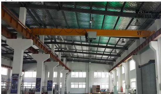
Obr. 1 Využitie krátkej konzoly v praxi: a) prefabrikovaná konštrukcia; b) hala s mostovým žeriavom.
