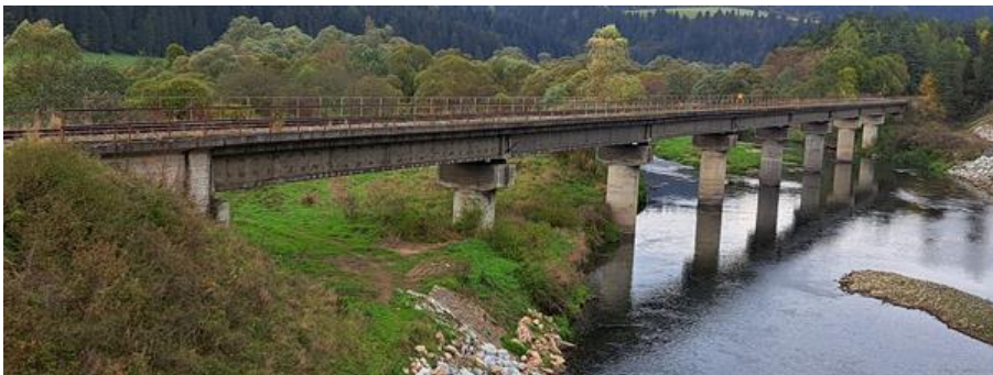
Obr. 1: Pohľad na mostný objekt
