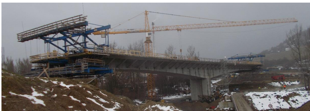
Obr. 7– SO211 Najväčší výsun vozíkov letmej betonáže
