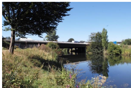
diaľničný most A648 cez rieku Nidda, Nemecko až 6 vrstiev uhlíkového betónu na vrchnej a spodnej strane 3,5 cm výstužná vrstva
