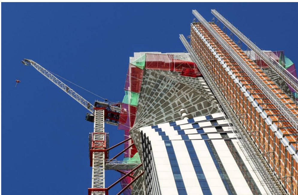
Obr. 8: Pohľad na točité poschodia
