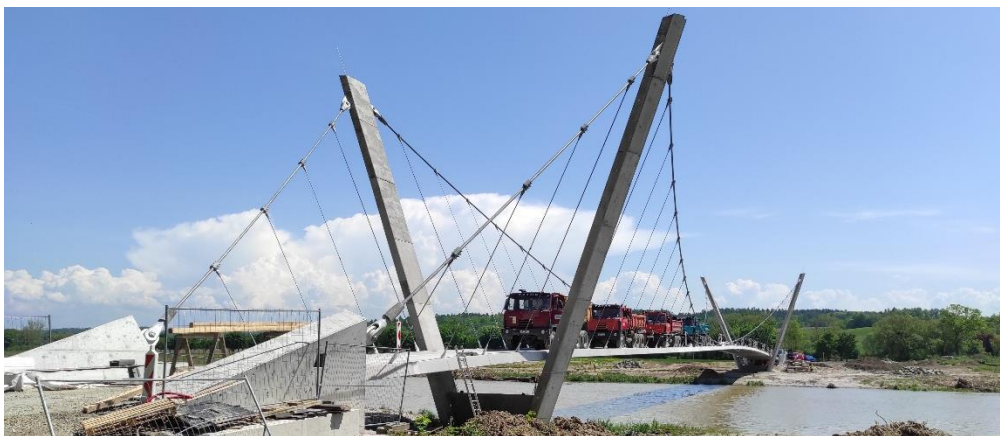
Obr. 8 – Statická zatěžovací zkouška
