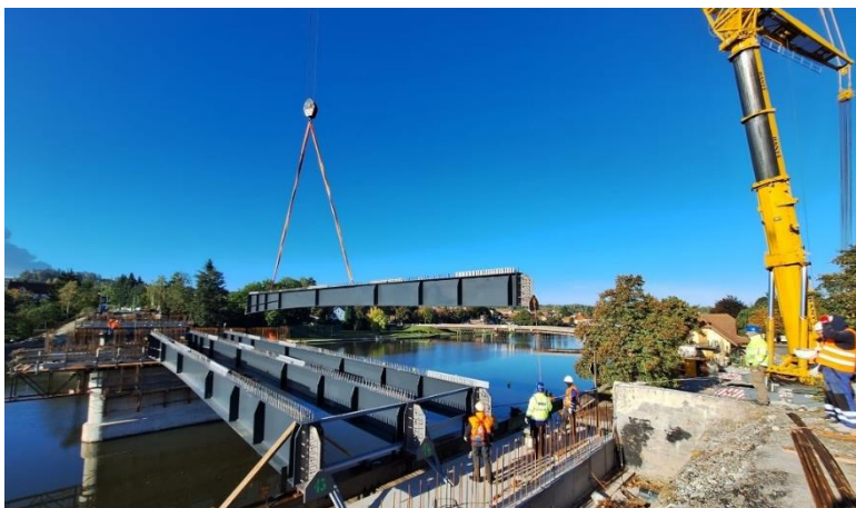
Obr. 4: Pohľad na osadzovanie nosníka krajného poľa mosta
