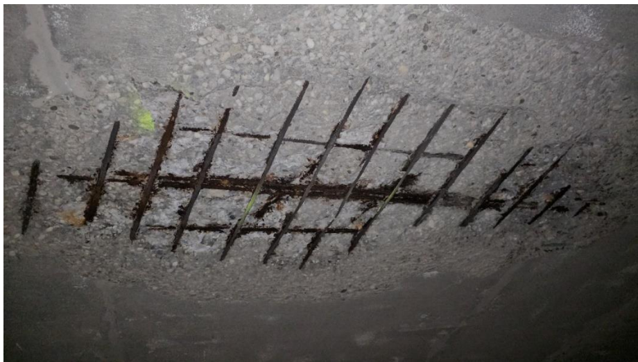
Obr. 1: Koróziou zasiahnutá výstuž
