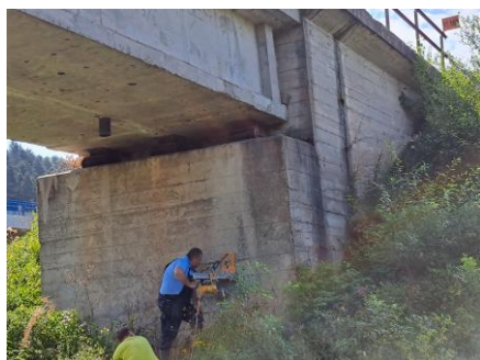
Obr. 2: Poruchy na moste – priesaky (netesnosť) cez dilatačné škáry na oporách (a), priesaky cez dilatačné škáry na nosnej konštrukcii (b)
