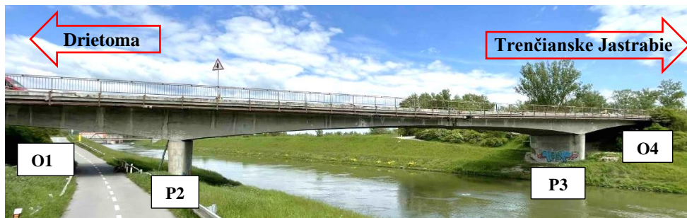
Obr. 1 – Pohľad na most pred rekonštrukciou
